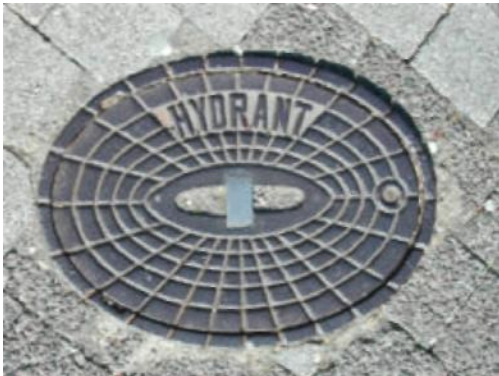
Abdeckung eines Unterflurhydranten
