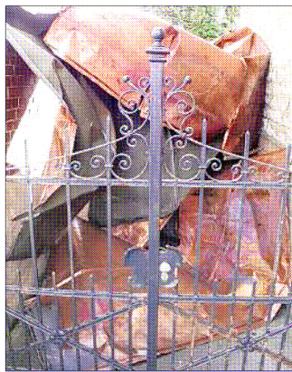
EIN KUPFERDACH ist jetzt nur noch ein Haufen Schrott.
