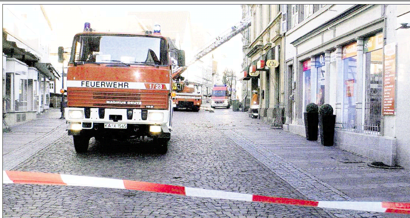
ABGESPERRT wurde gestern Nachmittag die Fußgängerzone, weil sich im Sturm an einigen Häusern Dachteile und Ziegel gelöst hatten. Von einigen Häusern waren Ziegel heruntergestürzt.
